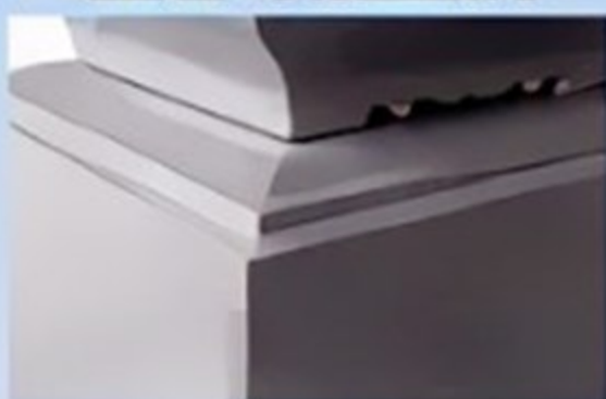
切り出し亀腹加工
